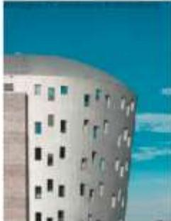
L'ACCIAIO utilizzato sia per le facciate che per le coperture è del tipo inossidabile AISI 304 oppure 306, due leghe speciali austenitiche per migliorare la saldabilità.
